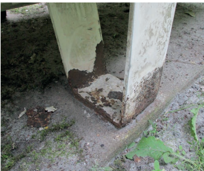
Tiefe Korrosion mit Werkstoffabtrag
