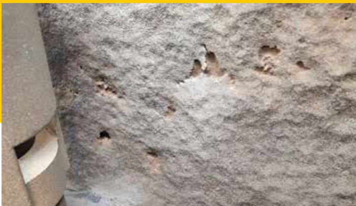
Vorbereitung des Schachts nach dem Trockeneisstrahlen
