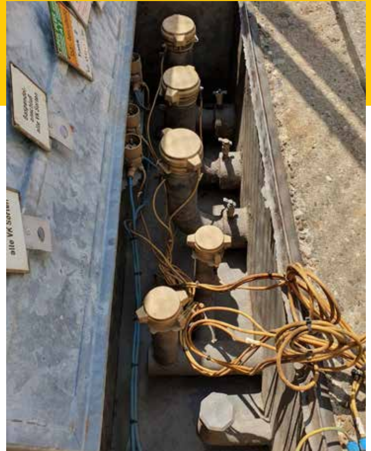
Schacht wurde komplett gestrahlt und von allen bindestörenden Stoffen befreit und gereinigt.
