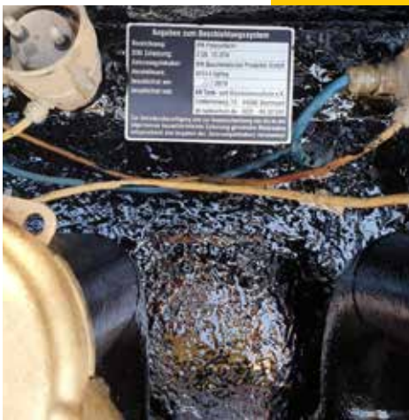
Fertigstellung nach Beschichtung: Das Zulassungsschild wird im Schacht angebracht.
