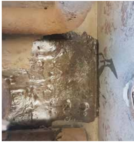
Die korrosionsbedingten Schadstellen in den metallischen Flächen werden überbrückt. Materialfehlstellen werden durch Einlegen spezieller Lamine aufgebaut. Die Schachtwände erhalten nach der Bearbeitung wieder ihre erforderliche Stabilität.
