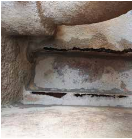
Die korrosionsbedingten Schadstellen in den metallischen Flächen werden überbrückt. Materialfehlstellen werden durch Einlegen spezieller Lamine aufgebaut. Die Schachtwände erhalten nach der Bearbeitung wieder ihre erforderliche Stabilität.
