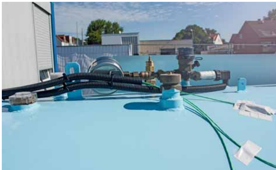
Anordnung des Drucktransmitters hinter dem Gasentnahmeventil zur Erfassung von Druckmesswerten.
